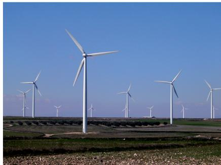
Estos molinos se llaman también aerogeneradores. El movimiento de sus aspas es el que permite obtener energía eléctrica.
